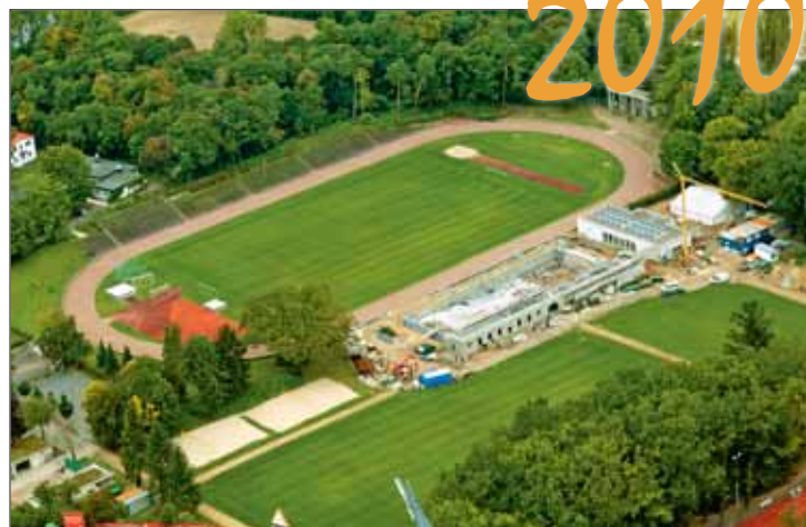
Das Hochschulstadion im Bau.
